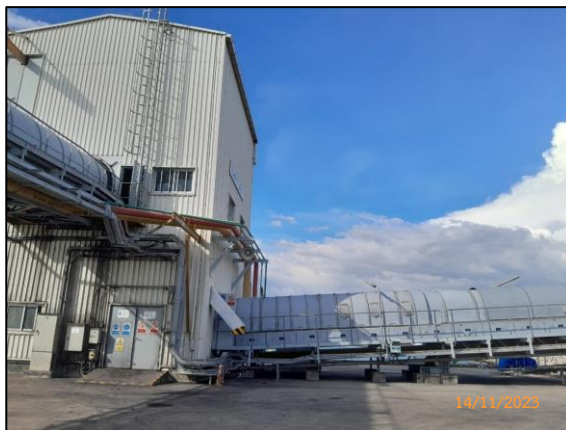
รูปที่ 2-5 การปิดคลุมสายพานลำเลียงถ่านหินบริเวณท่าเทียบเรือ ยกเว้นสายพานบริเวณหน้าท่า
