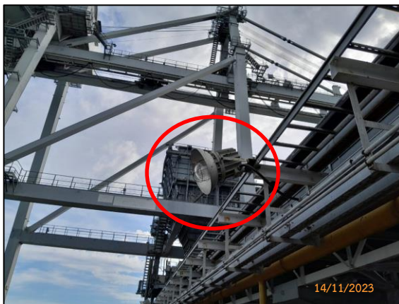
รูปที่ 2-28 การติดตั้งไฟส่องสว่างตลอดสายพานลำเลียงถ่านหิน และบริเวณท่าเทียบเรือ
