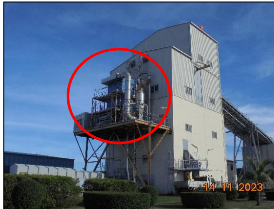
รูปที่ 2-10 ระบบ Dust Prevention Hood ที่ติดตั้งที่อาคาร Transfer Tower
